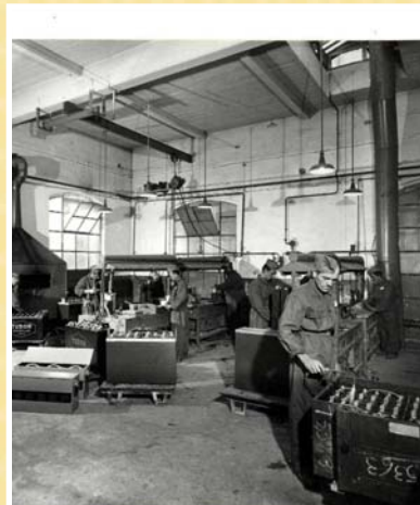
REPARTO Batterie per Trattore
