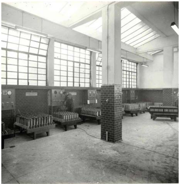
REPARTO CARICA BATTERIE ALCALINE
