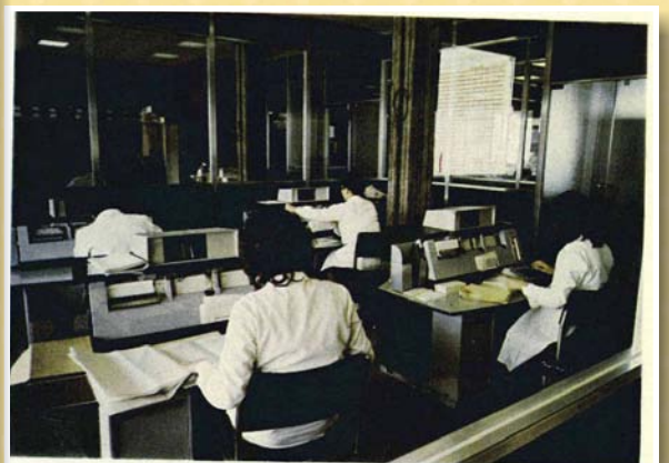
STABILIMENTO DI CASALNUOVO DI NAPOLI Centro elaborazione dati
